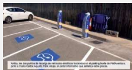
Antes, los dos puntos de carga de vehículos eléctricos instalados en el parking hotel de PortAventura, para el Hotel Costa Aquila Park, hoy, se han trasladado a este nuevo punto.
