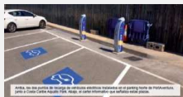
Antes, los dos puntos de carga de vehículos eléctricos instalados en el parking hotel de PortAventura, para el Hotel Costa Aqueduct Park. Ahora, se están instalando para facilitar más puntos.
